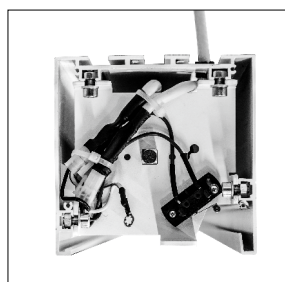
Elektroinstalace včetně dodatečného mikrosplínače
